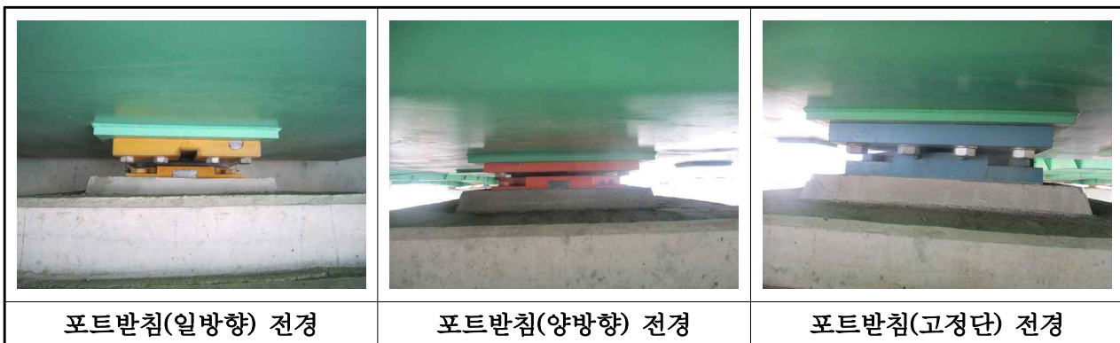
【사진 3.13】 교량받침 전경
