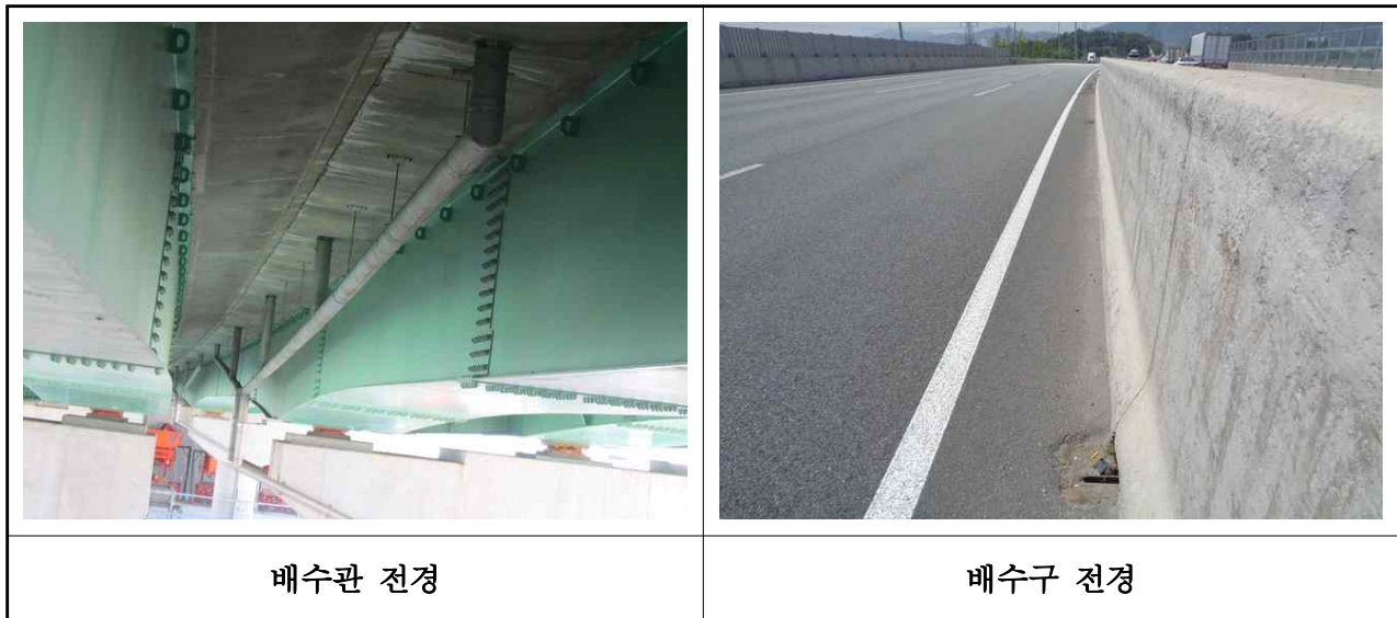
【사진 3.21】 배수시설 전경
