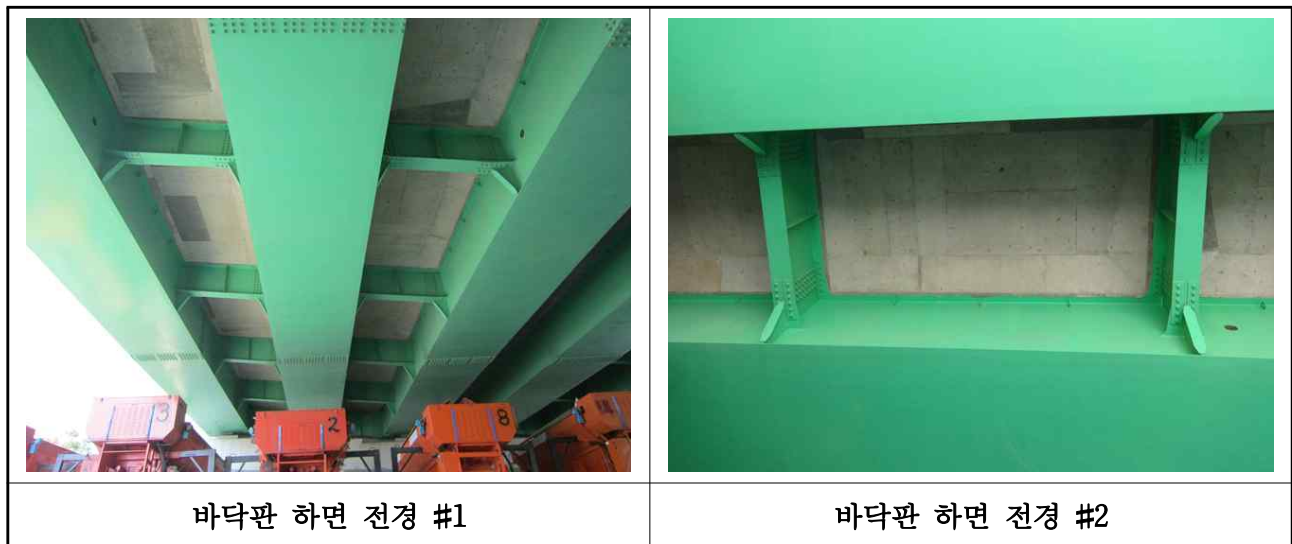
【사진 3.2】바닥판 전경
