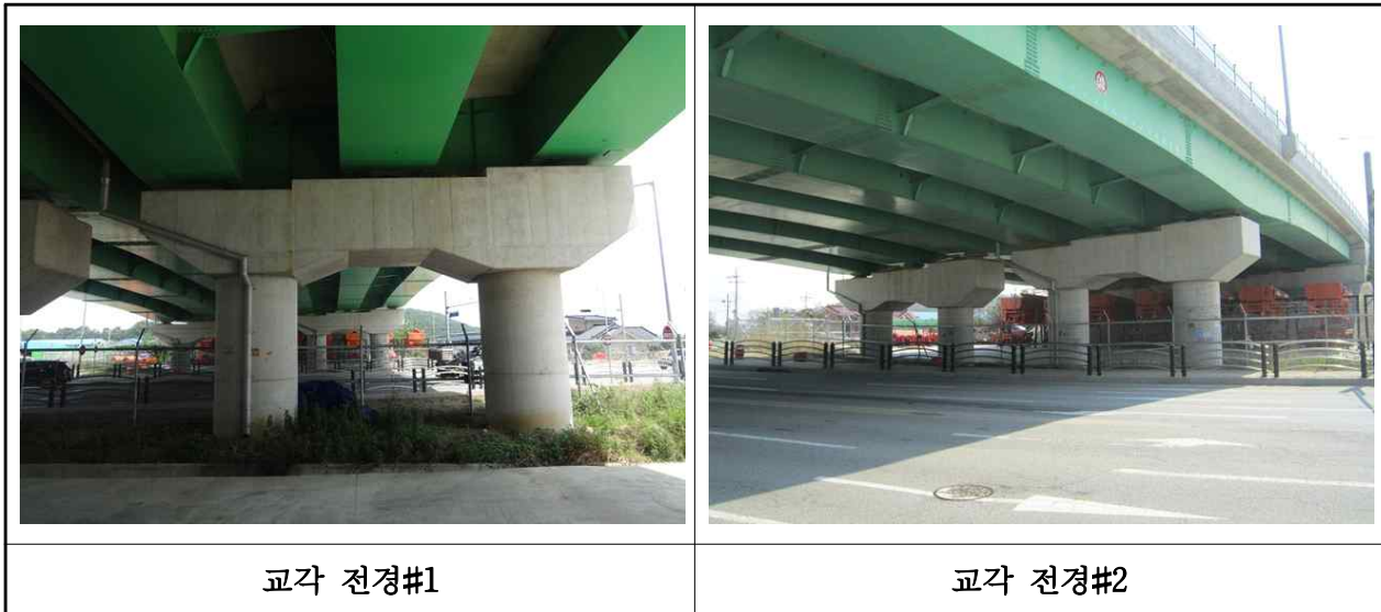
【사진 3.11】 교각 전경
